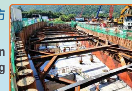
東涌河公園的訪客中心的地庫現正進行防水膜安裝工程 Installation of waterproofing membrane at the Visitor Centre of Tung Chung River Park
