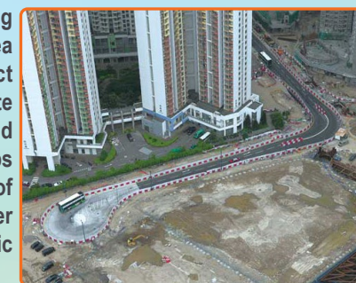
已完成L4路段 Completion of Road L4
