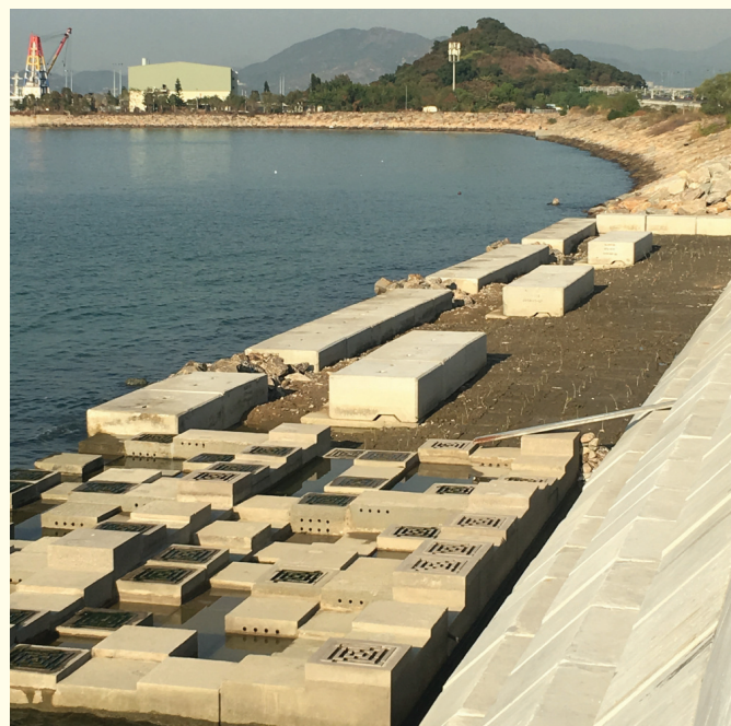
位於小蠔灣的生態海岸線試驗場 Trial site for eco-shorelines at Siu Ho Wan
