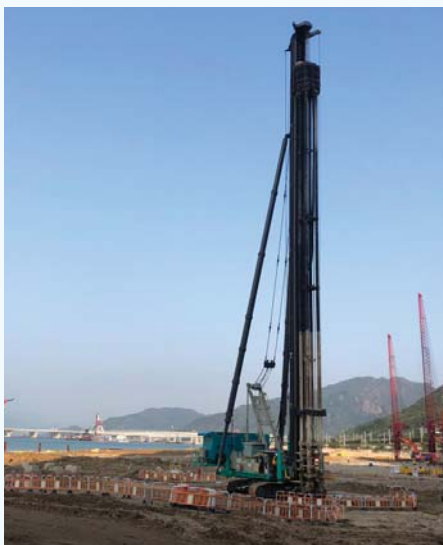
深層水泥拌合法工程 Deep cement mixing works
