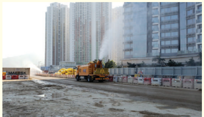
使用車輛作流動式灑水 Mobile water spraying truck
