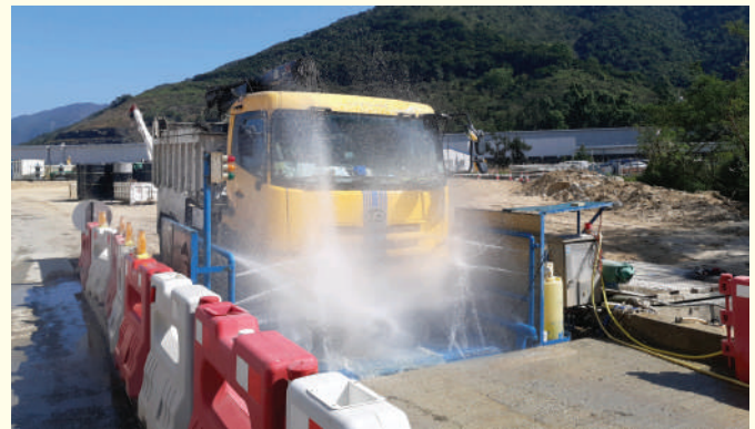
自動車輪清洗設施 Automatic wheel washing facilities
