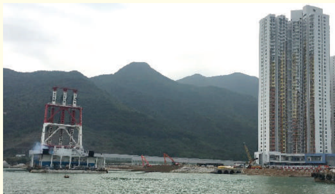
深層水泥拌合法工程 Deep cement mixing works
