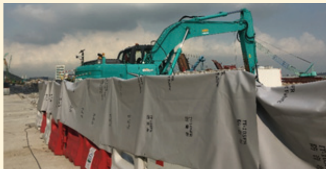
採用移動式的隔音屏障
