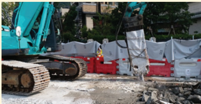
採用隔音布減低噪音水平
