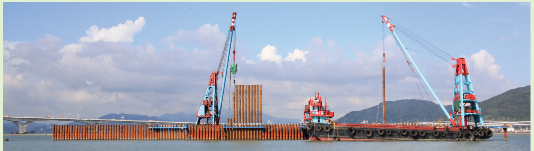
右圖：安裝鋼管樁 以作臨時防波堤
